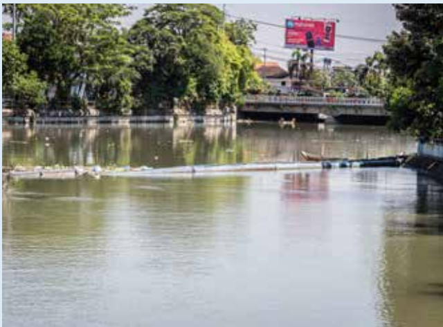
Floating barrier, Sidoarjo
